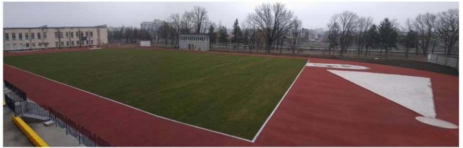
Будівництво стадіону ЦДПУ
