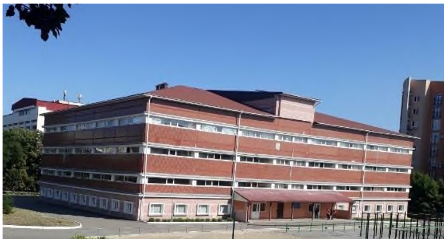
Капітальний ремонт покрівлі корпусу № 2 ДДУВС
