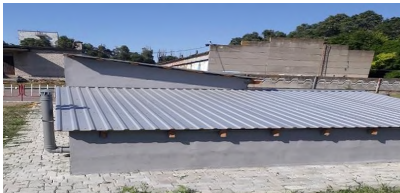
Додатковий ввід води з боку вул. Полігонна, м. Дніпро
