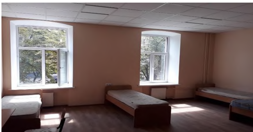
Капітальний ремонт 2-го поверху корпусу № 9 (казарма) ДДУВС
