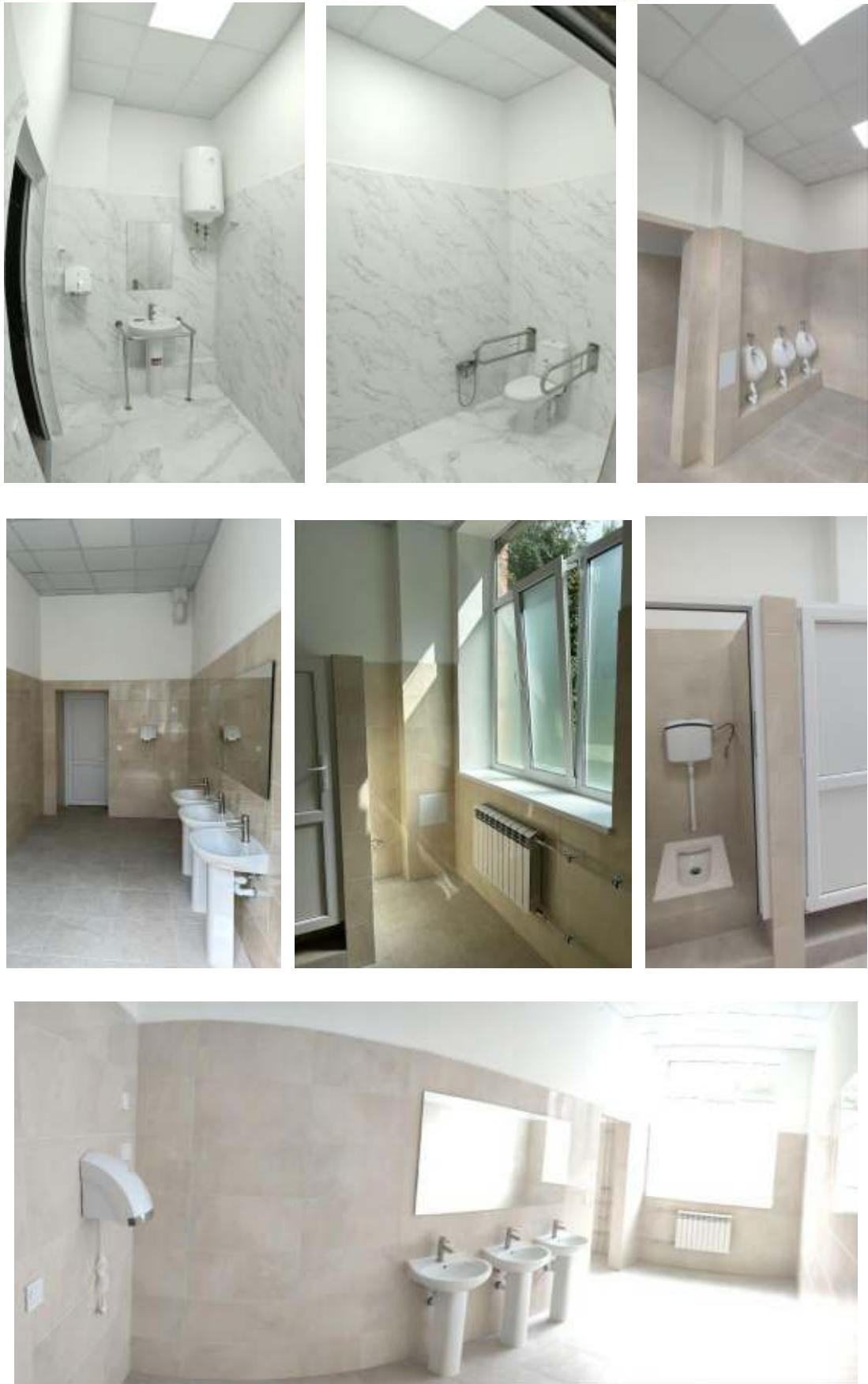
Рисунок 10.2 - Туалет першого поверху навчального корпусу №2 після завершення капітального ремонту
