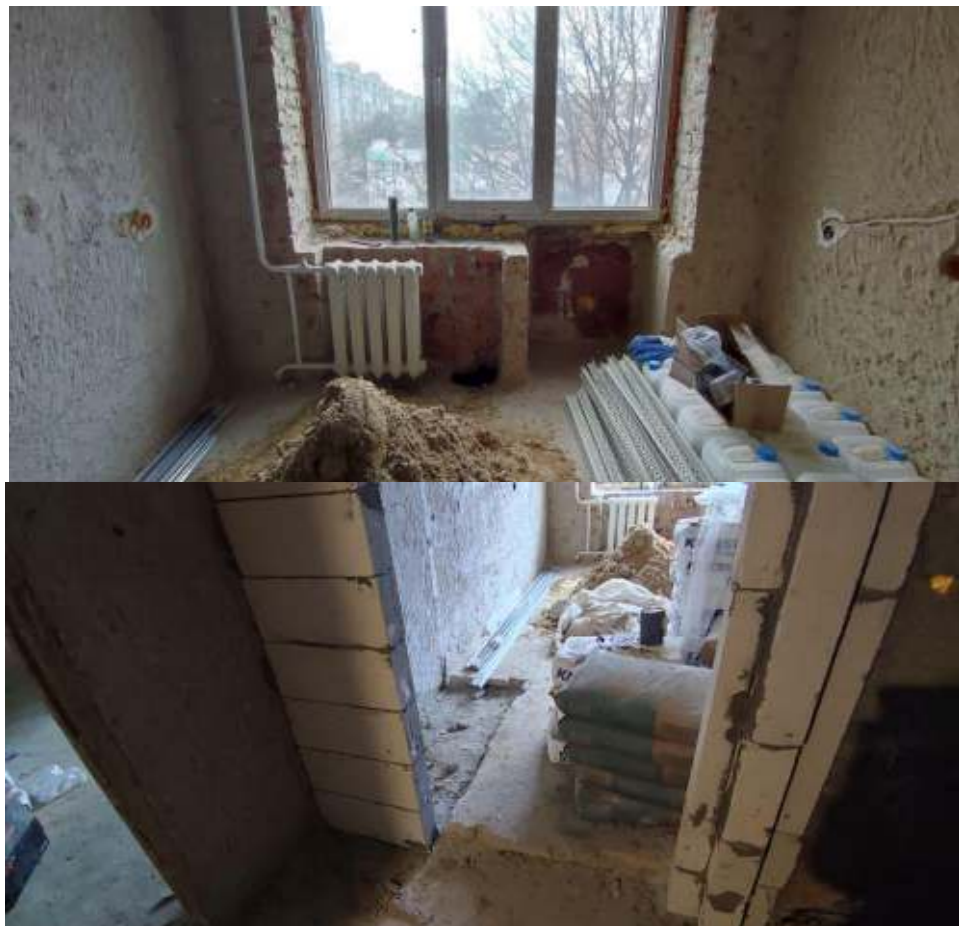
Рисунок 10.4 - Стан приміщень 5 поверху гурт. №3 під час виконання ремонтних робіт
